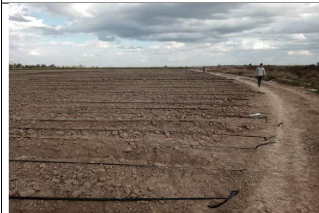
Druppelirrigatieleidingen geïnstalleerd februari 2023
